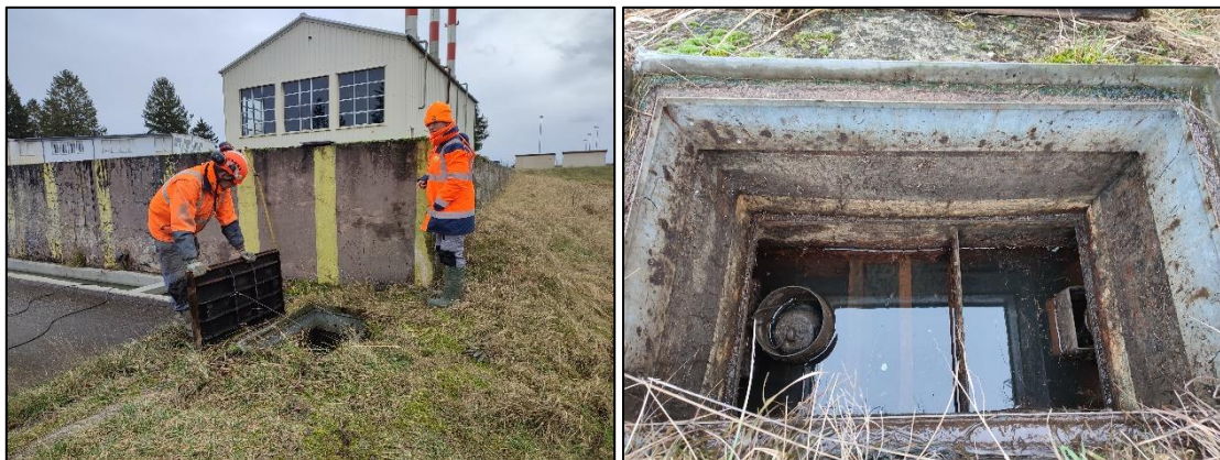
Figure 21. Photographies du séparateur à hydrocarbures localisé au nord-ouest de la rétention.
